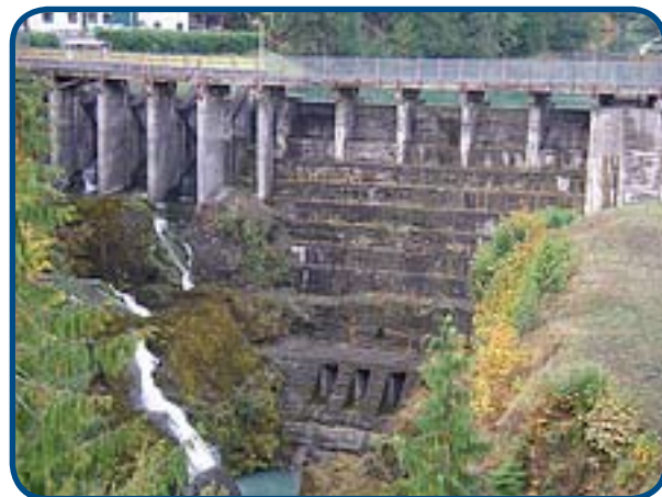
Elwha Dam, WA
